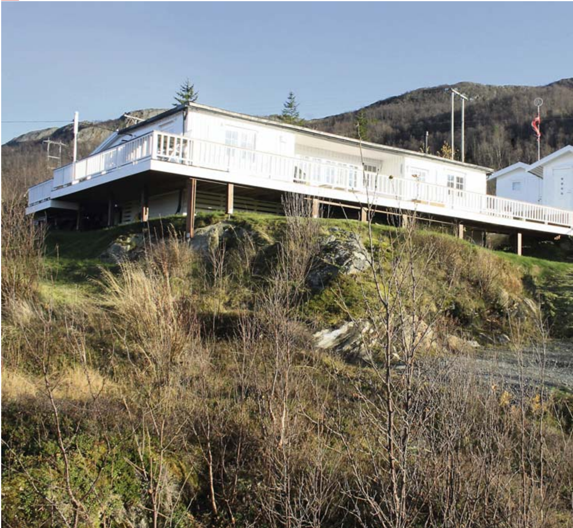
TRE ANNEKS: Hytta til familien Urke, som for øvrig ligger noen kilometer sør for Bjerkvik, har tre anneks, ett til hvert av barna deres. Mye av byggingen av hytta ble gjort av Arvid Sølve Urke og sønnen
